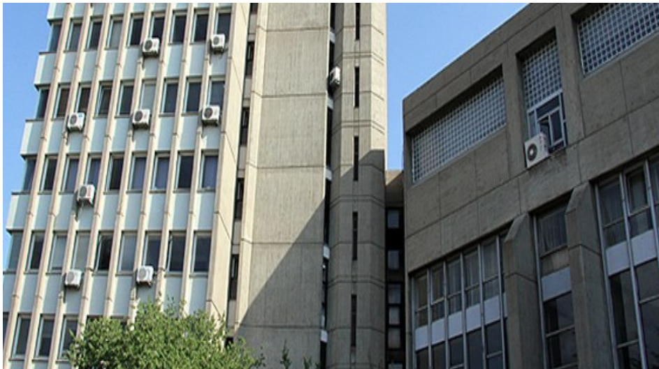
FBE—Merkez Mühendislik Binası, 1-2-3. Katlar
